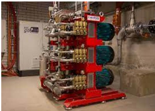
Ilustración 9 grupo contra incendios de sistema de agua nebulizada de alta presión (izquierda) y grupo contra incendios de sistema de agua nebulizada de baja presión (derecha)
