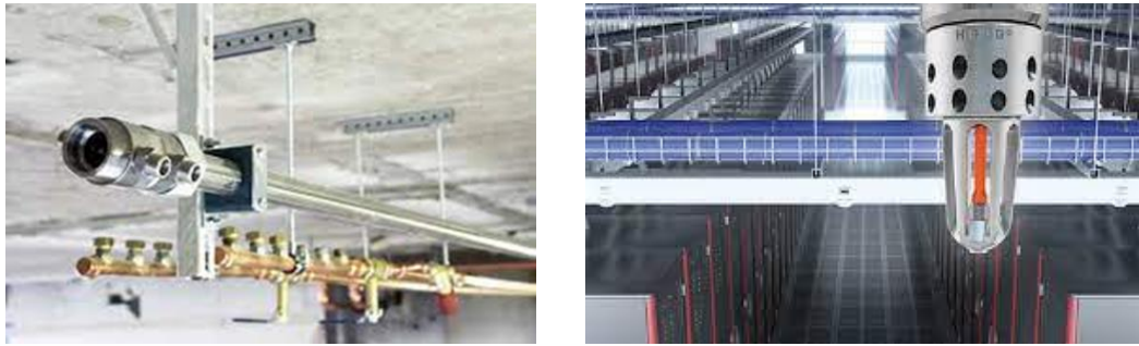
Ilustración 8 Sistema de tubería de acero inox. y boquilla cerrada de sistema de agua nebulizada de alta presión
