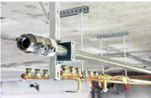
Ilustración 6 Sistema de tubería de acero inox. y boquilla cerrada de sistema de agua nebulizada de alta presión
