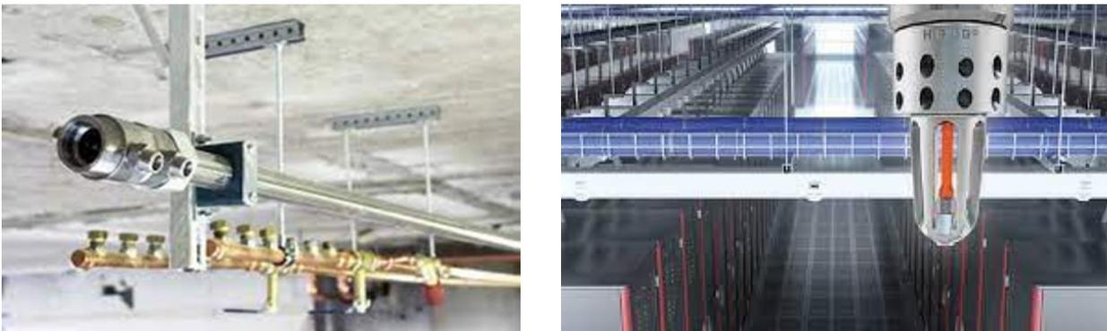
*Ilustración 6 Sistema de tubería de acero inox. y boquilla cerrada de sistema de agua nebulizada de alta presión*
